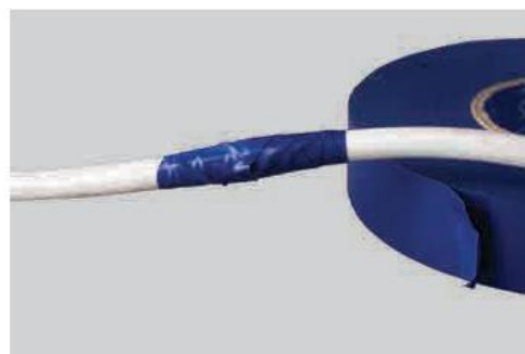
d) Kiểm tra, bọc kín chỗ cách điện bị hỏng trên vỏ dây dẫn
