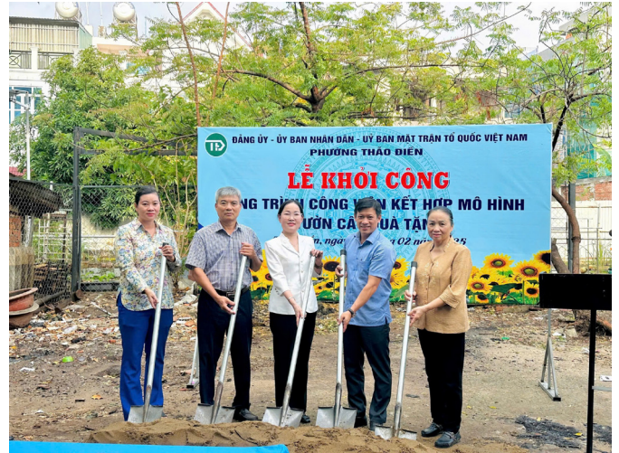
Lãnh đạo Đảng ủy - UBND - UB.MTTQ Việt Nam phường Thảo Điền và đại diện Cấp ủy, hộ dân khu phố thực hiện nghi thức khởi công công trình.
