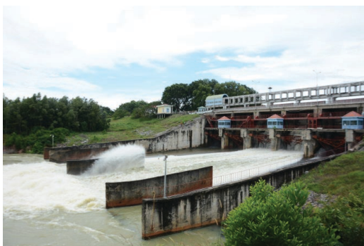
Hình 1. Đập tràn hồ thủy lợi Dầu Tiếng, huyện Dương Minh Châu, tỉnh Tây Ninh trong một lần xả nước (Nguồn: tuoitre.vn)
