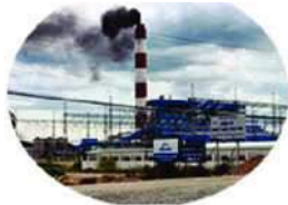
Nhà máy nhiệt điện
