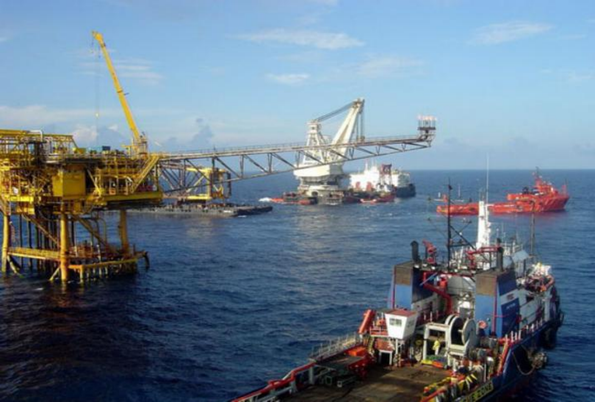
Sơn chống ăn mòn kết cấu thép các công trình trên biển
