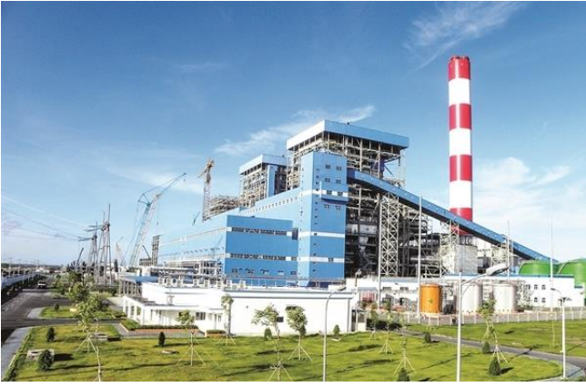
Nhà máy nhiệt điện Phả Lại
