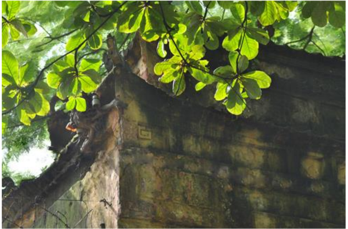
(Cổng dẫn vào điện Kính Thiên được xây gạch với kiểu nóc mái chông 2 lớp)
