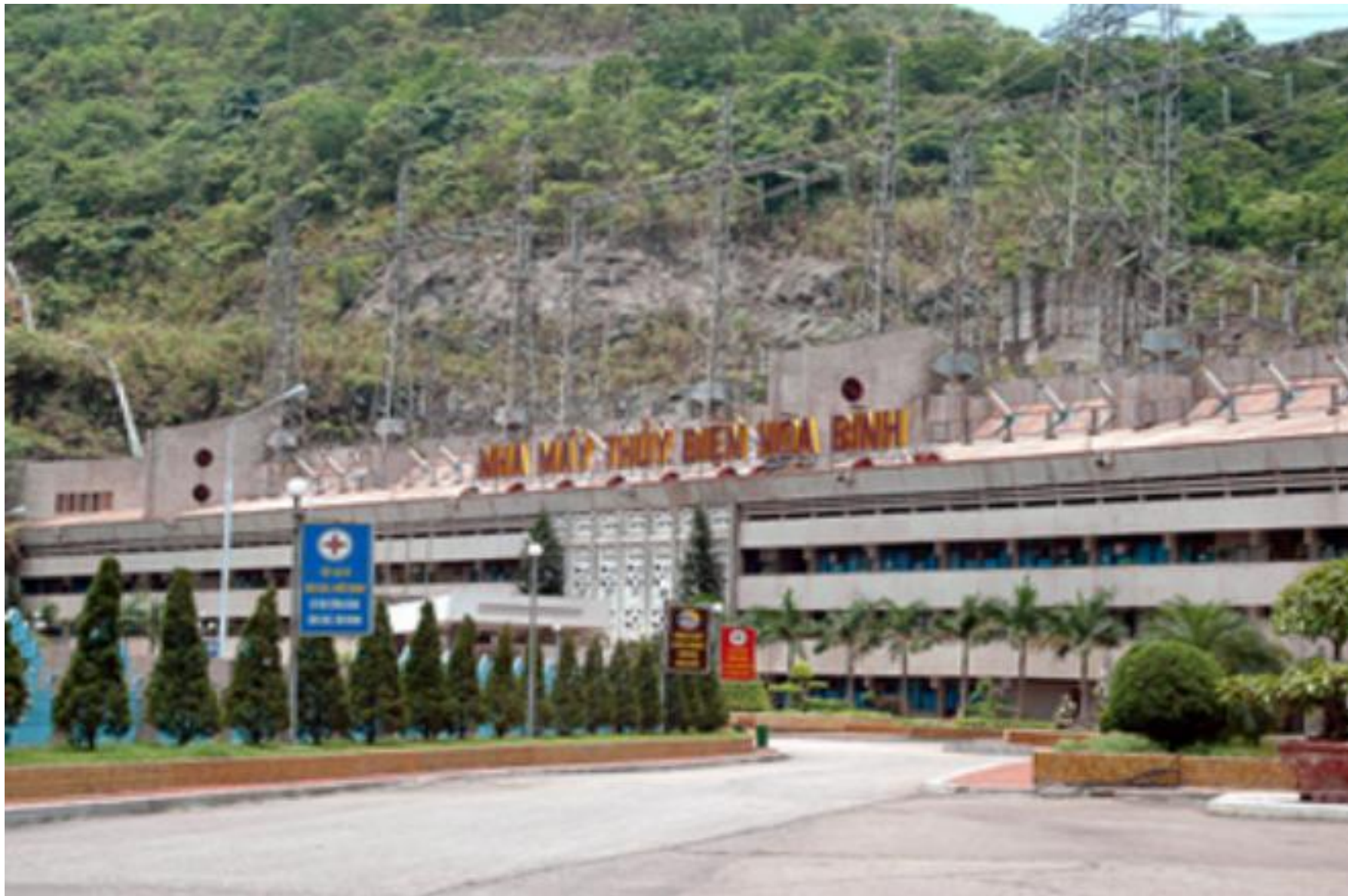
Nhà máy thủy điện Hòa Bình- Sự hợp tác giữa Liên Xô và Việt Nam
