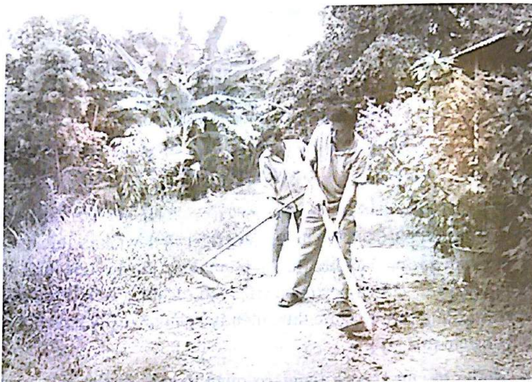
Đoạn đường trong ấp Tân Long được làm từ nguồn quỹ hỗ trợ lúa nước do người dân đóng góp
