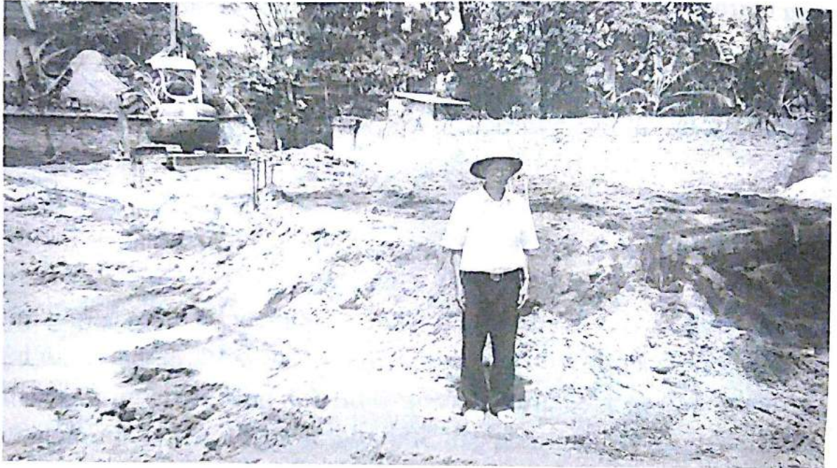
Ông Nguyễn Đắc Hội bên công trình Nhà Văn hóa thôn Nam Liếp đang thi công
