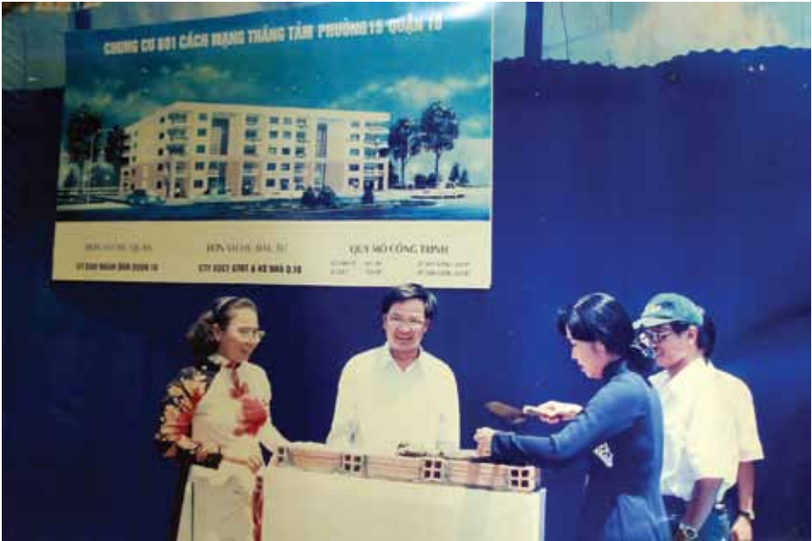
Lãnh đạo Quận 10 tại Lễ đặt viên gạch đầu tiên xây dựng chung cư 601 Cách Mạng Tháng Tám tại Phường 15
