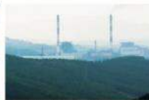
▲ Hình 10.8. Nhà máy nhiệt điện
