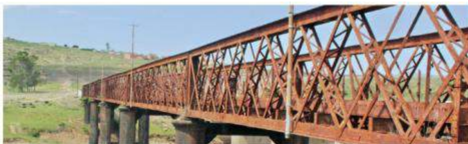
▲ Hình 11.3. Cầu sắt bị hoen gỉ theo thời gian
