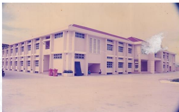
Toàn cảnh khu trường mới xây
